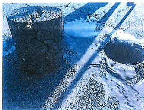
Fotografia . Rdzeń poszczególnych warstw konstrukcyjnych
