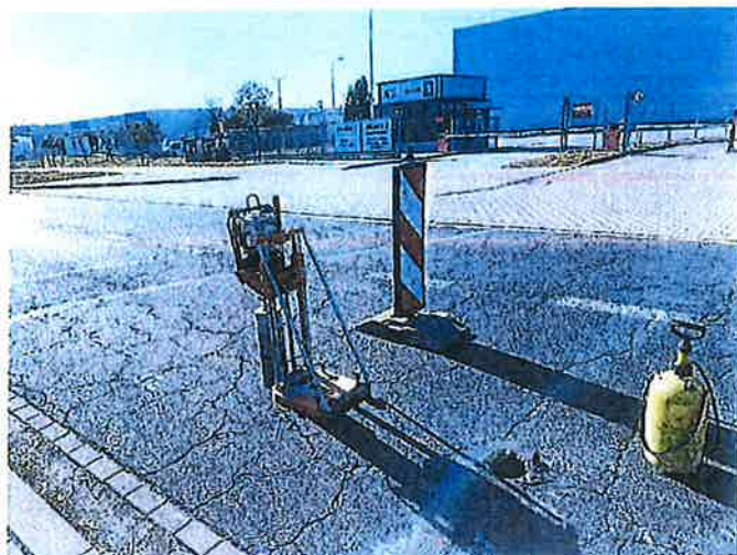
Fotografia . Widok ogólny miejsca wiercenia
