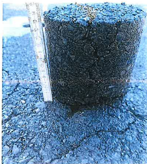
Fotografia . Rdzeń poszczególnych warstw konstrukcyjnych
