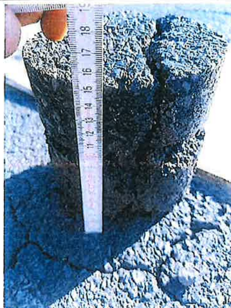
Fotografia . Rdzeń poszczególnych warstw konstrukcyjnych
